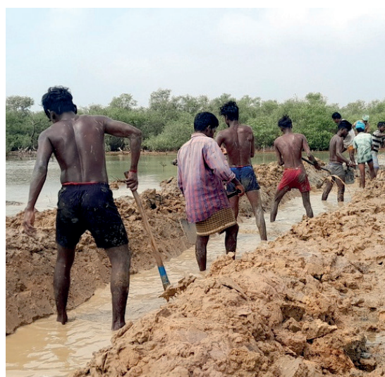
Das Ausheben der Fischgräten-Kanäle ist aufwändig und schwere körperliche Arbeit.
